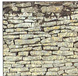
Mur en pierres plates à joints vifs
