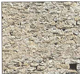
Moellons de calcaire à joints beurrés
